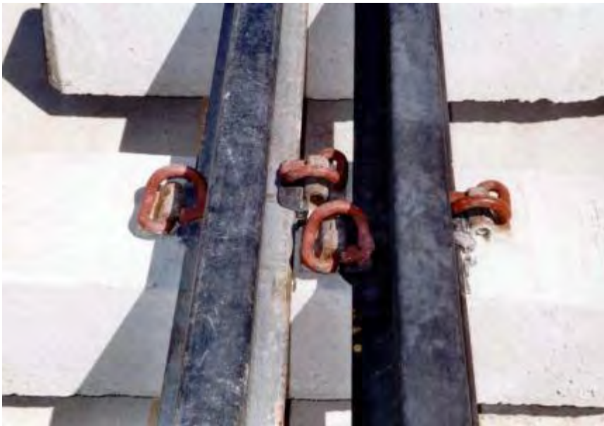
Sujeción Pandrol en el diseño inicial.
